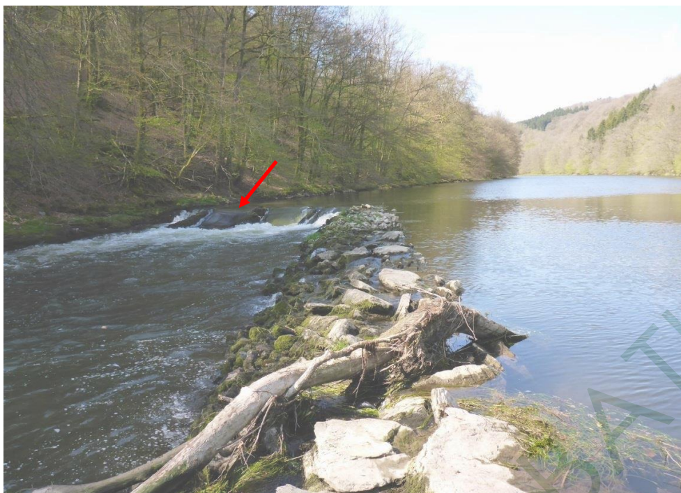
De dam van de Vanne des Moines, met een doorgang langs de rechteroever (vaak moeilijk te passeren, sterke stroming). Voorzichtigheid is geboden. Mogelijkheid om aan de rechterkant uit te stappen en de boot voorbij de dam te dragen, om zo de afdaling per boot te vermijden.
