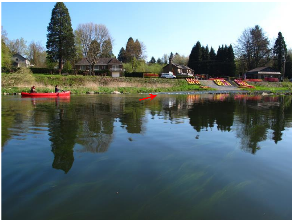
14 – L'ancien barrage au niveau de l'aire « La Vanne » à Alle s/Semois. Il se franchit par la gauche (aisé).
